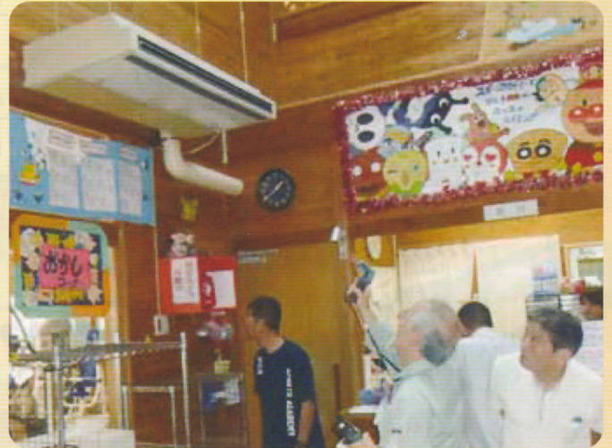
天井のエアコン吹き出し口の温度測定
